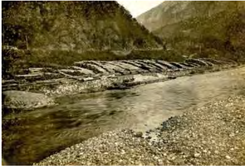
大野田土場の遠景
