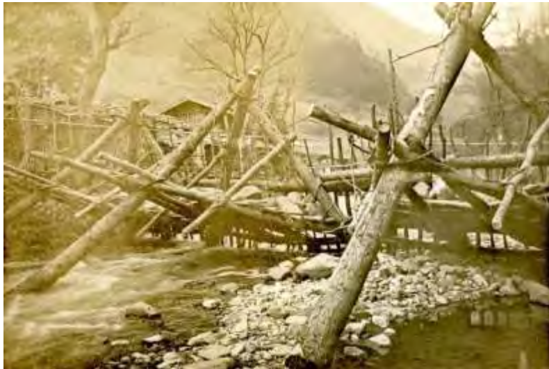
流送された薪材の引き上げのための装置(近景)
