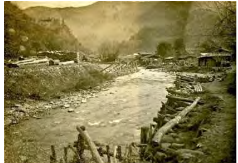
流送された薪材の引き上げのための装置(遠景)
