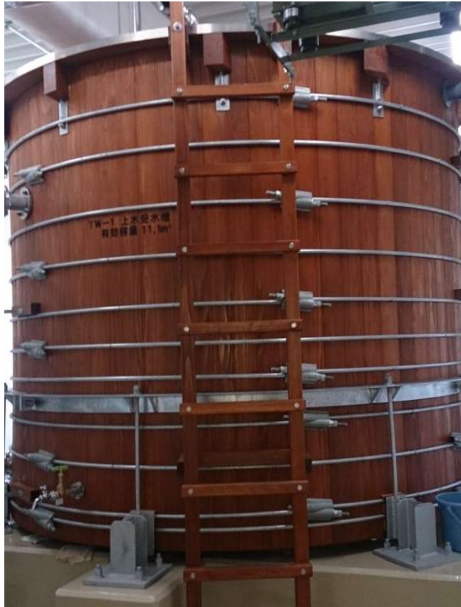
木製受水槽(豊田市役所)
