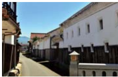
Shirakabe Storehouses (Kurayoshi City)
