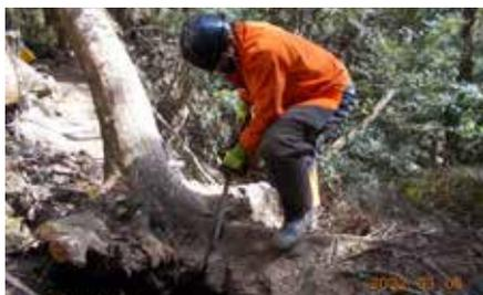
左/関東ふれあいの道(モミ・ツガのみち)。倒木により谷側が崩落し一枚岩になったため、ステップを山側に移設しパイプ支柱を打ち込み手摺養生を設置した
