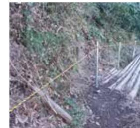
崩落個所に設置した橋と手摺
