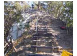
金山ダム・元清澄山間の崩落個所のステップ移設(山側へ)及びロープ養生
