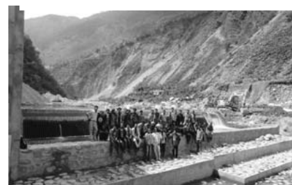
JICA 西ネパール小水力発電所取水口工事
