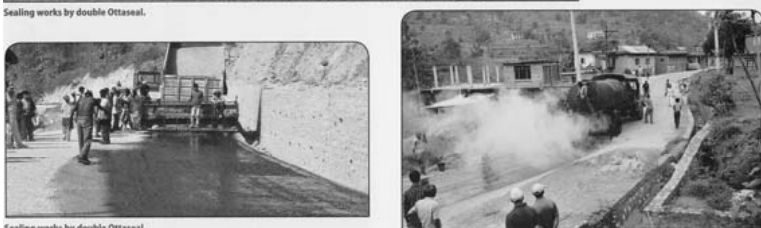
メラムチ・アクセスロード工事
